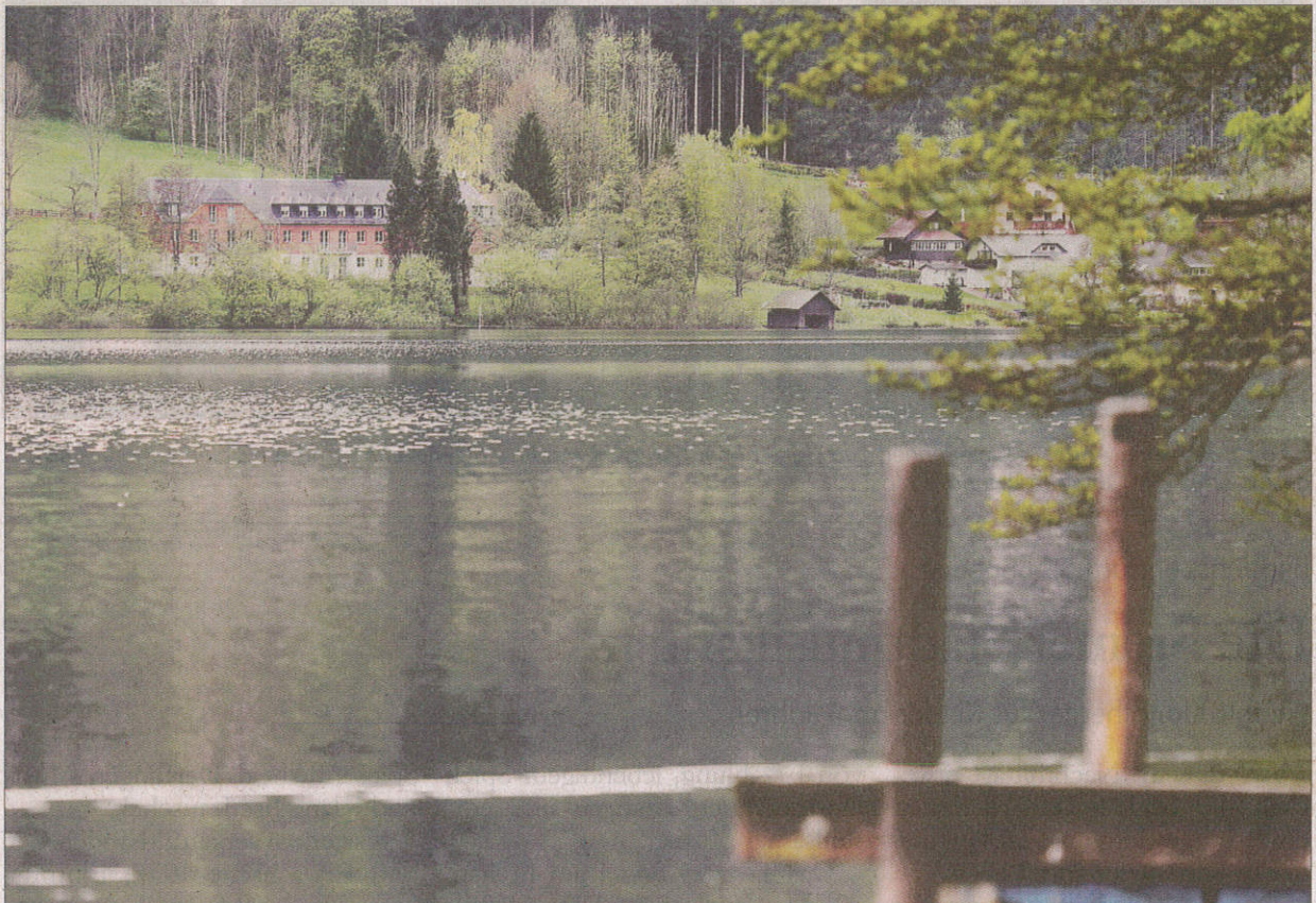
Außenansicht des WasserClusters Lunz, der in der ehemaligen biologischen Station am hinteren Seeufer gelegen ist.
